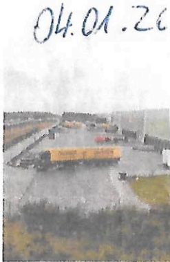
Blick auf das Logistikzentrum, das ausgelastet ist
